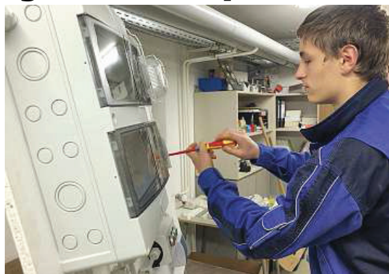
Auszubildender Pascal Ziermann montiert im Lehrkabinett des Unternehmens eine komplette Sicherungs- und Verteilanlage für Wohnhäuser.
