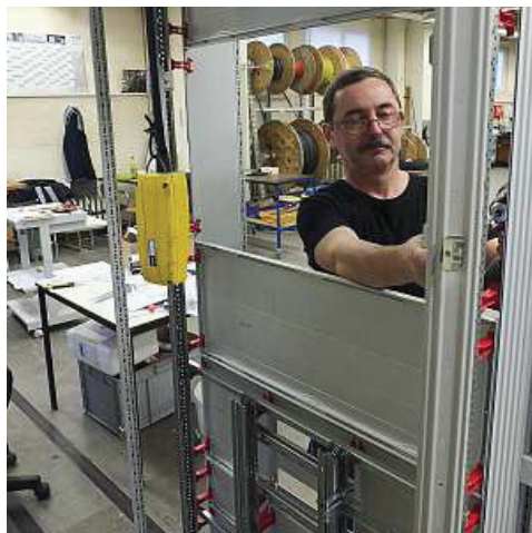
Jens-Uwe Rau montiert Schaltschränke für einen Industriekunden.
